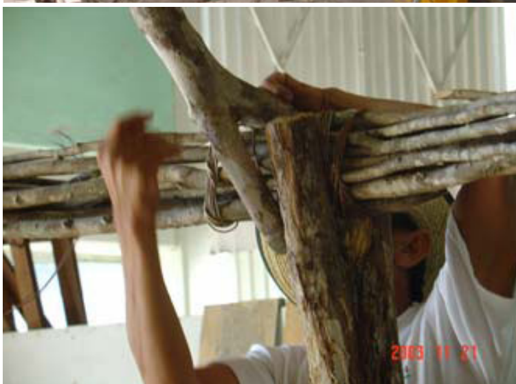
Figuras 29 y 30 Modelo de una estructura tipo en laboratorio. Foto Isis Rodríguez Pérez.
