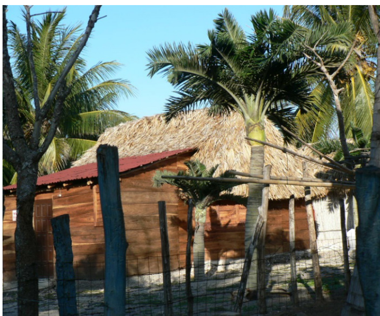
Imagen 10 Casa fabricada con tablonces de madera y huanos (casa de playa recién construida por un particular) en la localidad del Cuyo, Tizimín, Yucatán. Foto: Martín Jesús Asencio Cetina.
