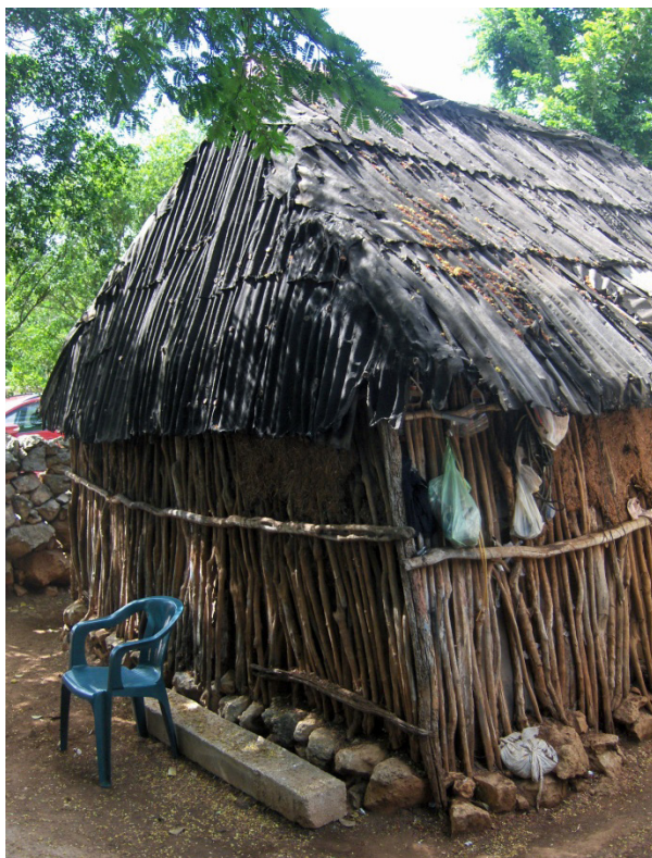
Figura 11 Vivienda vernácula de planta rectangular con cubierta de lámina de cartón en Dzununcan, Yucatán. Foto: Arturo Román.
