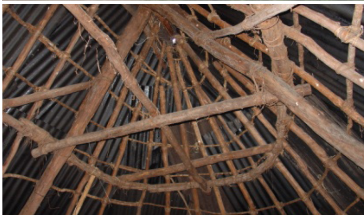
Figuras 8 y 9 Cambio de la paja en cubierta por láminas de cartón. Fotografías: Isis Pérez R. Catálogo de casas mayas en la costa.
