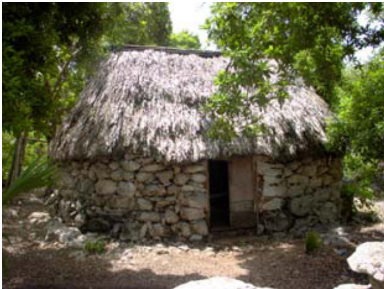
Figura 20 Muro de mampostería de piedra. Foto Isis Rodríguez.
