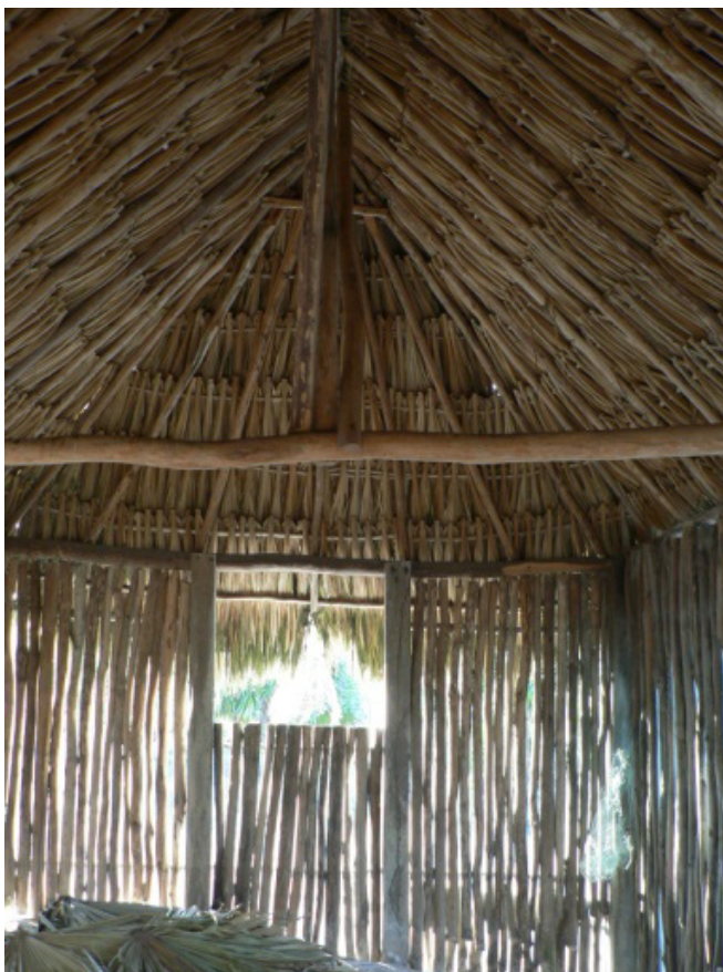
Imagen 8 Interior de una casa recién construida en la localidad del Cuyo, Tizimín, Yucatán. Foto: Alejandro Campos Hijuelos.
