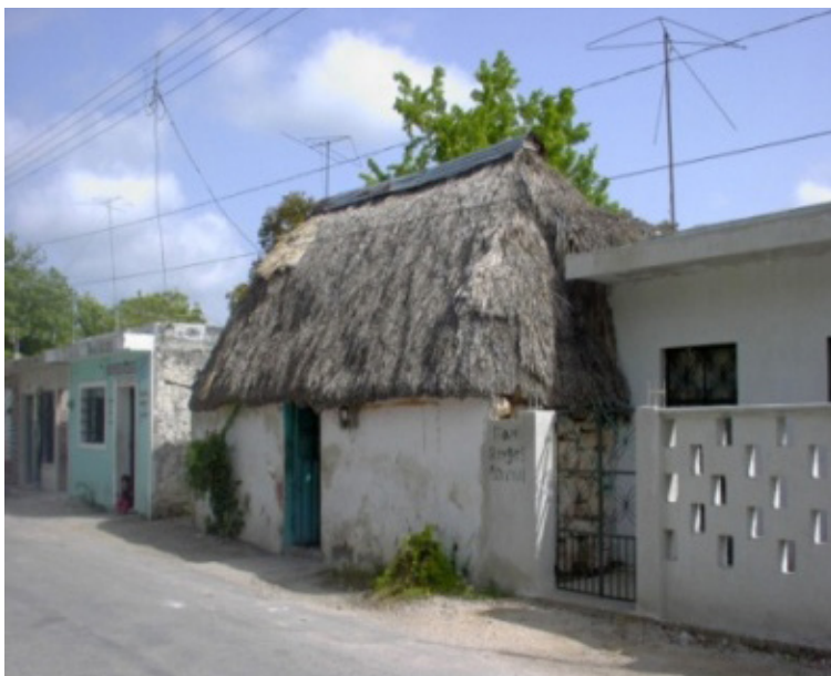
Figura 11 Transformaciones de la casa y solar maya. Foto: Isis Rodríguez. Catálogo de casas mayas en la costa.
