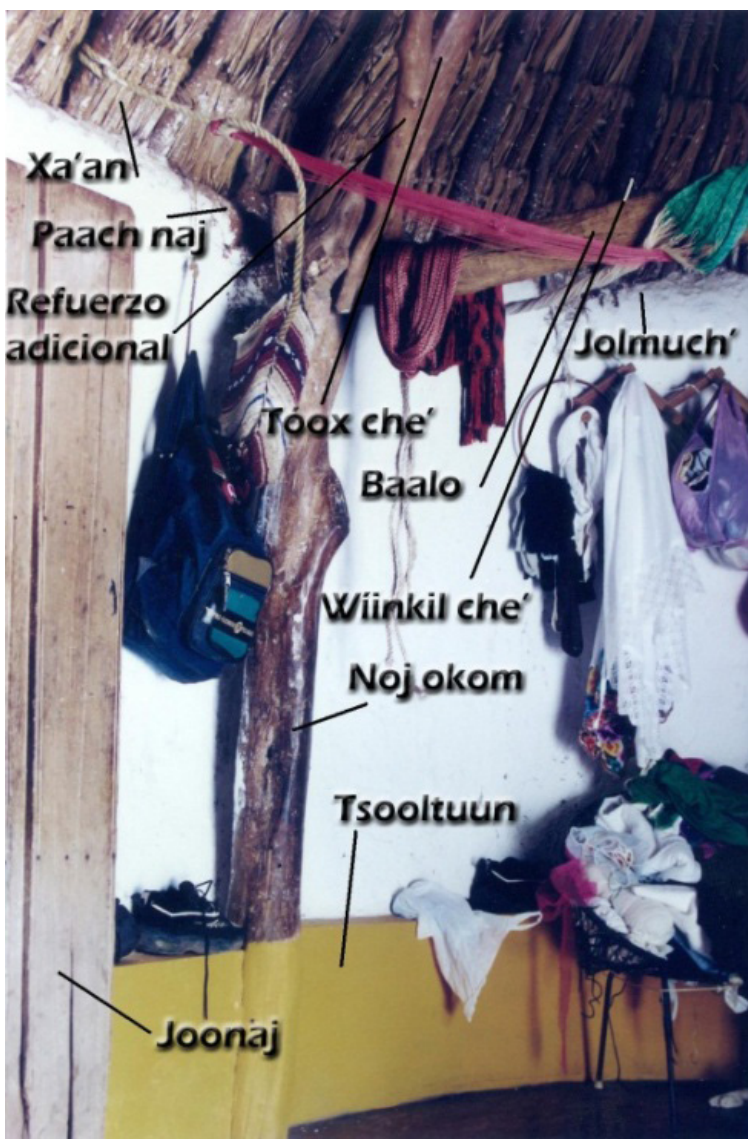
Figura 5 Elementos estructurales que soportan la cubierta. Tenabo, Campeche. Foto Aurelio Sánchez.
