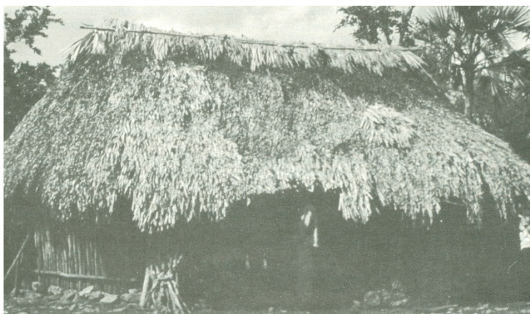
Figura 11 Casa-habitación terminada mostrando la pared kolokche' y el madero que lo sostiene kopche' .
