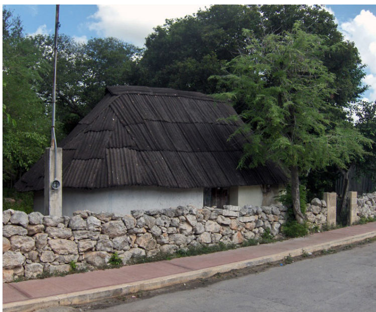
Figura 10 Vivienda vernácula de planta absidal con cubierta de lámina de cartón en Dzununcan, Yucatán. Foto: Arturo Román.
