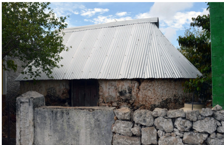
Figura 12 Vivienda vernácula con sustitución de la cubierta vegetal por lámina de zinc en Dzibichaltún, Yucatán. Foto: Aniela Piñón.
