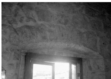
Izquierda: Figura 25. Enlace de dovelas de platabanda y jambas de marco de ventana con muro de sillares, casa del cura Juan Bruno de Luna. Derecha: Figura 26. Capialzado de piedra de cantería aparejada concéntricamente, que enlaza a los dos paramentos del muro. Palacio Episcopal.
