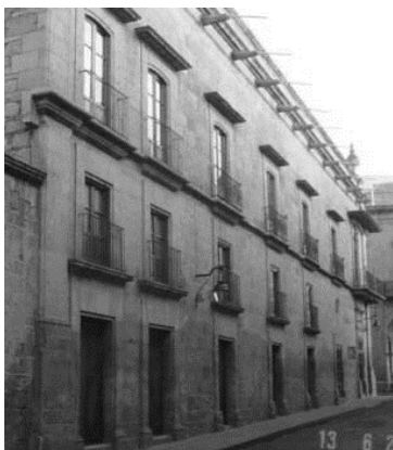
Figura 30. Vanos de puertas y ventanas a plomo unos sobre otros, casa de Isidro Huarte.
