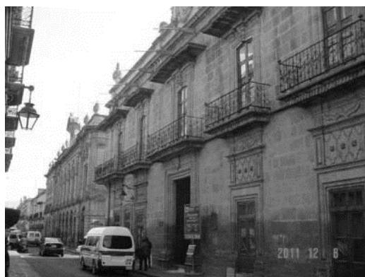
Figura 18. Aleros, balcones y faja en fachada de la casa de Isidro Huarte.
