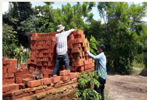
Imagen 135. Toma de muestra de tabiques
