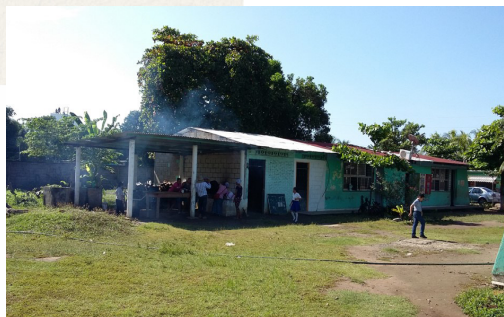
Imagen 55. Cocina sin instalaciones
