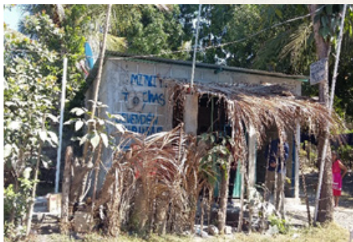
Imagen 9. Vivienda. Bloque hueco y lámina
